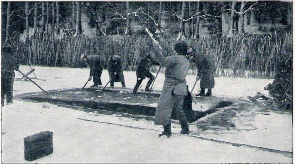
266. 110. Die Eissholle wird untergeschoben.
